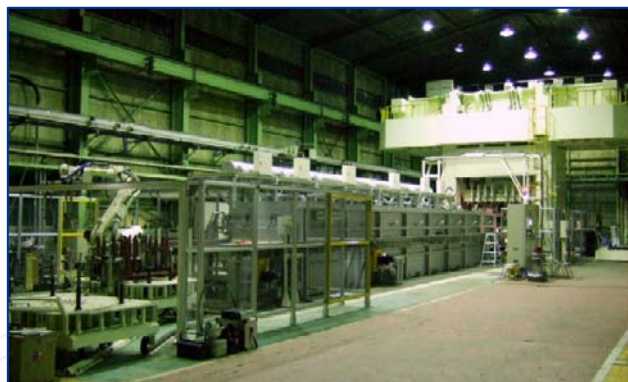
ホットスタンプ量産設備
