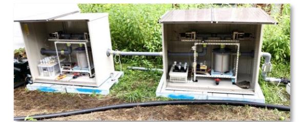
農業用水路での連結運転検証
